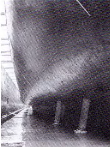
De romp van de Olympic doemt op in het droogdok. De geklonken staalplaten en de kimkiel zijn duidelijk zichtbaar.
