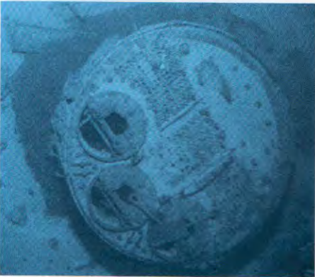
Eén van de vijf eenzijdig gestookte ketels uit ketelruim 1.
